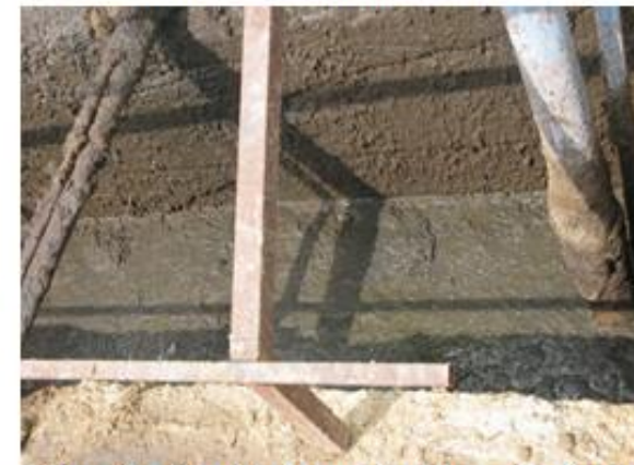
Fig. 48. Fosă intermediară pentru dejeții lichide lângă adăpost
