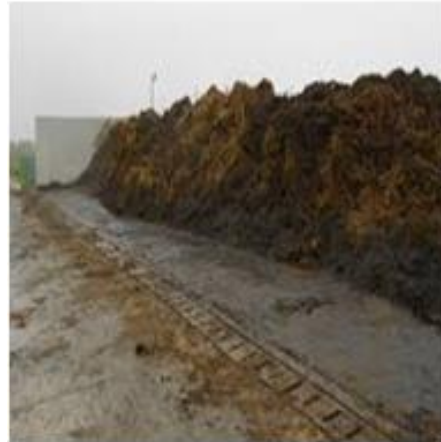
Fig. 55. Platforma individuală de beton în câmp
